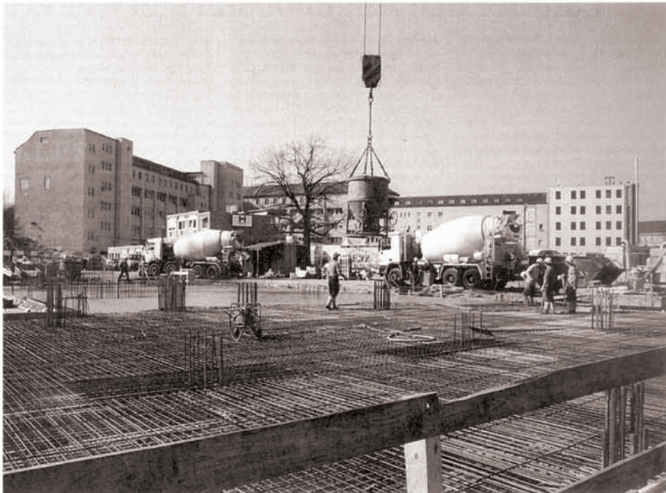
Gelungen ist die Standardisierung des so genannten elektronischen Lieferscheins für Transportbeton. Damit ist die Voraussetzung gegeben, um künftig durch unternehmensübergreifende Baustoff- und Baustellenlogistik markante Qualitäts-, Zeit- und Kostenvorteile auf der Baustelle zu realisieren.
